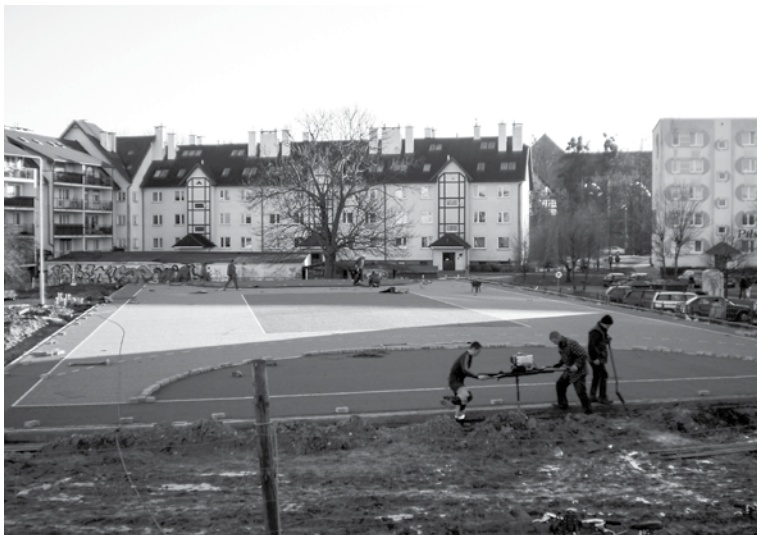
Budowa boiska wielofunkcyjnego
