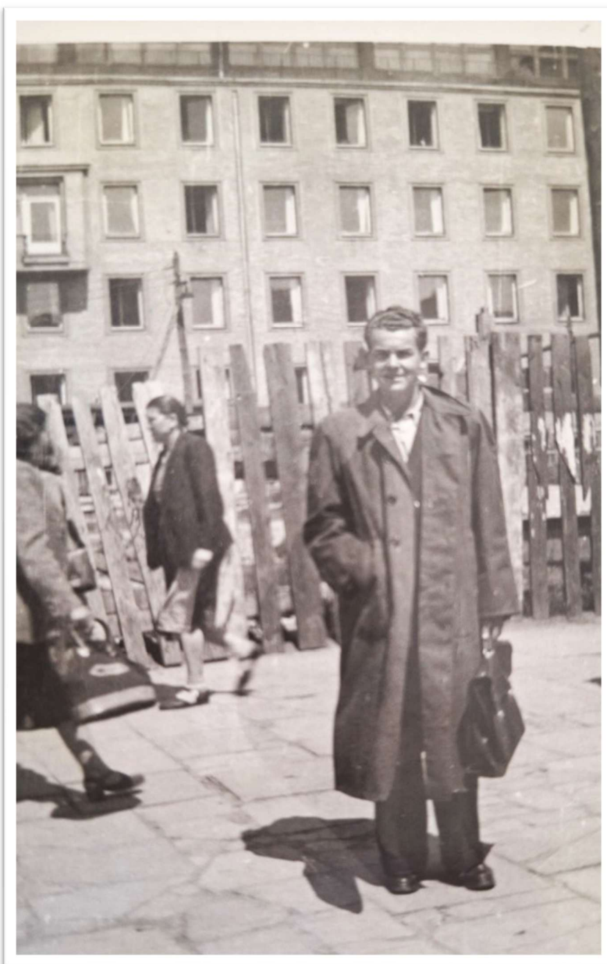
Ryc. 27. Jerzy Erwin na tle budowy nowych bloków mieszkalnych w Szczytnie (koniec lat. 50 XX w.).
