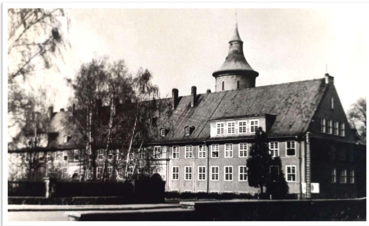
Ryc. 1. Widok na budynek szkoły, w której w latach 1946–1970 funkcjonowało m.in. Liceum Ogólnokształcące. Tutaj w latach 1959–1968 była zatrudniona Ligia Jeżewska. Szczytno, ul. Jana Kasprowicza 1.
