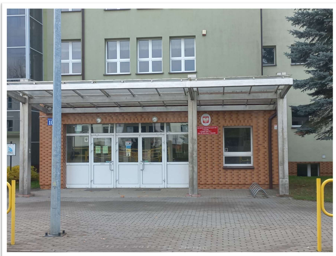
Ryc. 15. Współczesny widok na wejście do budynku Liceum Ogólnokształcącego, w którym Telesfor Kocięcki pracował w latach 1970–2001.
