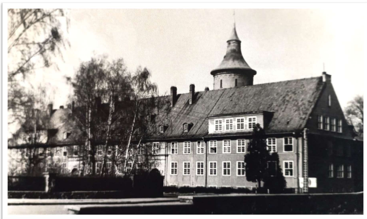
Ryc. 8. Widok na budynek szkoły, w której w latach 1946–1970 funkcjonowało m.in. Liceum Ogólnokształcące i w którym Stanisław Konstanty nauczał wychowania technicznego w latach 1964–1970. Szczytno, ul. Jana Kasprowicza 1.
