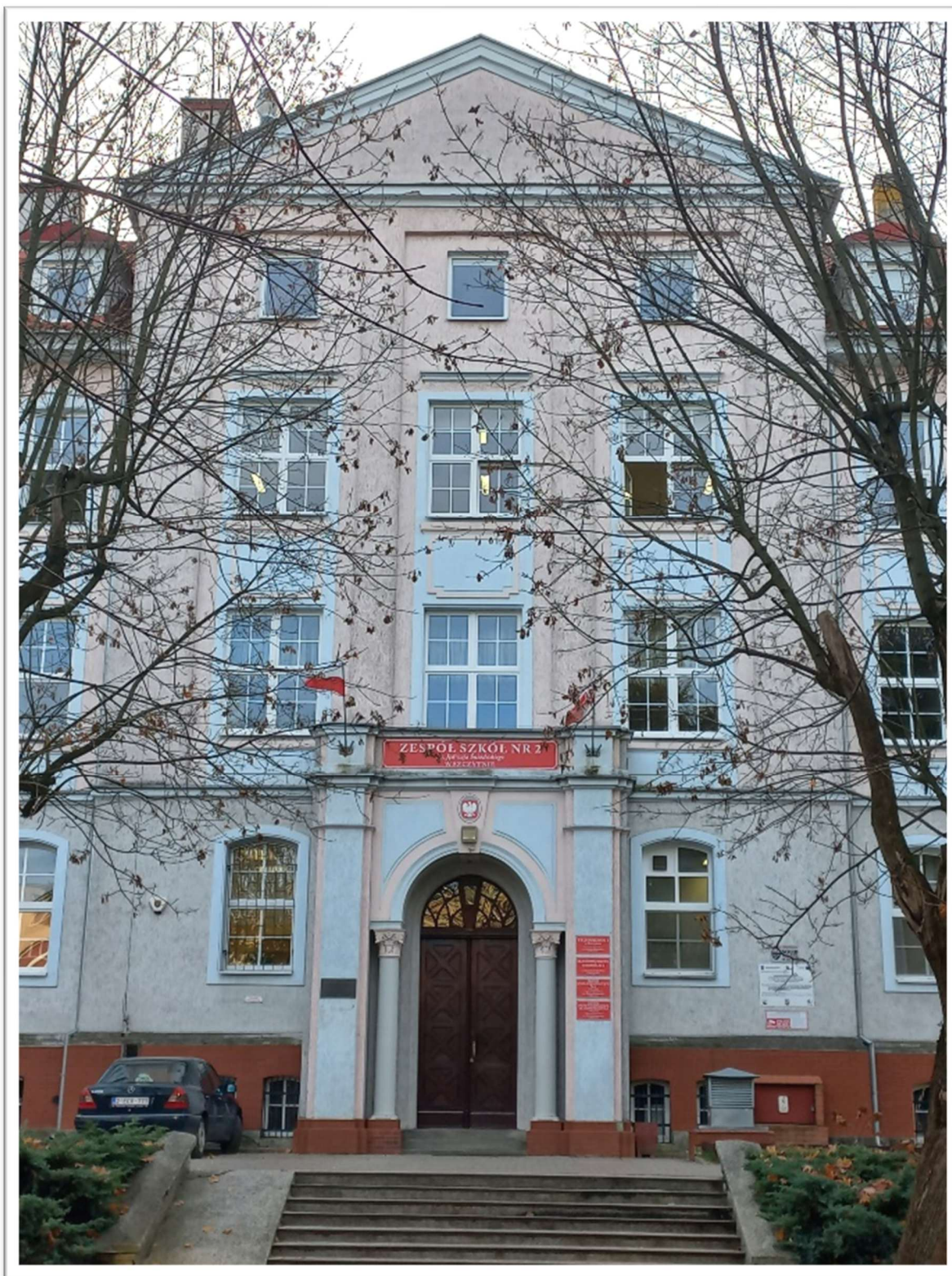
Ryc. 3. Współczesny widok na wejście główne do Zespołu Szkół Zawodowych nr 2 w Szczecinie przy ulicy Polskiej 18.
