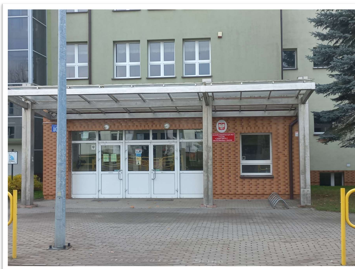
Ryc. 8. Współczesny widok na wejście do budynku Liceum Ogólnokształcącego, w którym Maria Stępkowska pracowała w latach 1970–1973.
