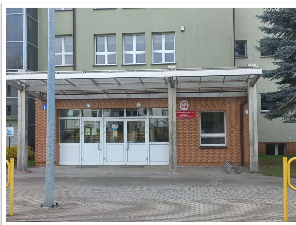
Ryc. 6. Współczesny widok na wejście do budynku Liceum Ogólnokształcącego, w którym Lidia Szyposz pracowała w latach 1973–1997.
