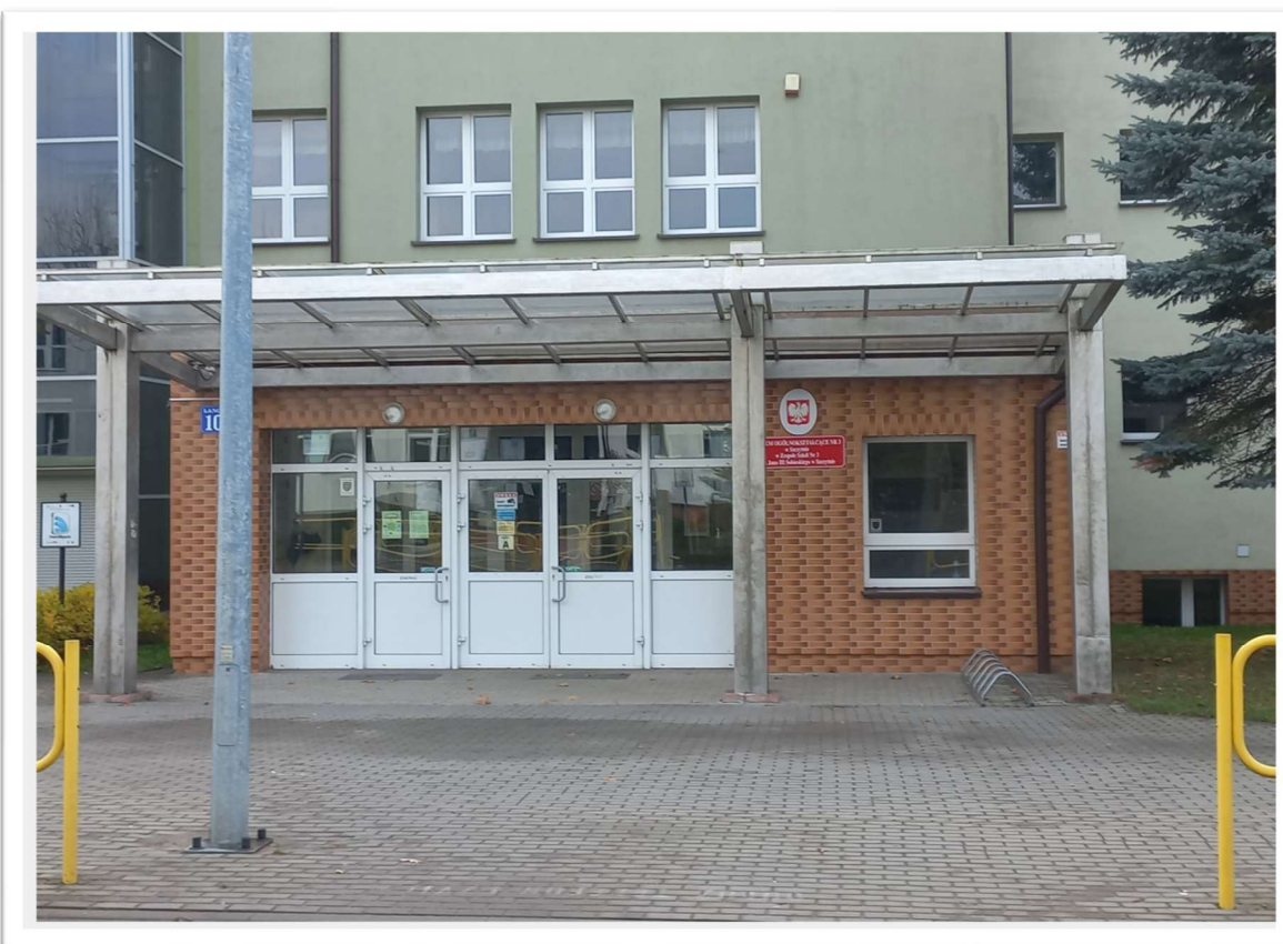
Ryc. 12. Współczesny widok na wejście główne do budynku Liceum Ogólnokształcącego w Szczytne przy ulicy J. Lanca 10, w którym Helena Tarlecka pracowała w latach 1973–1975.
