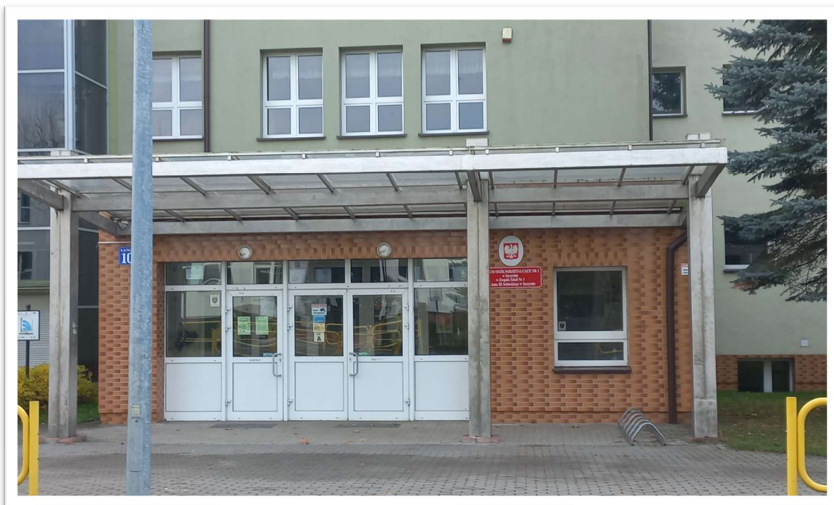
Ryc. 7. Współczesny widok na wejście do budynku Liceum Ogólnokształcącego, w którym Krystyna Trzcińska pracowała w latach 1973–1991.
