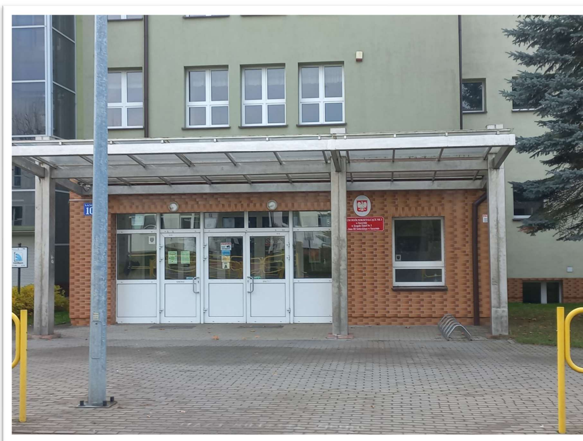
Ryc. 56. Współczesny widok na wejście do budynku Liceum Ogólnokształcącego, w którym Marian Brechelke pracował w latach 1970–1974.
