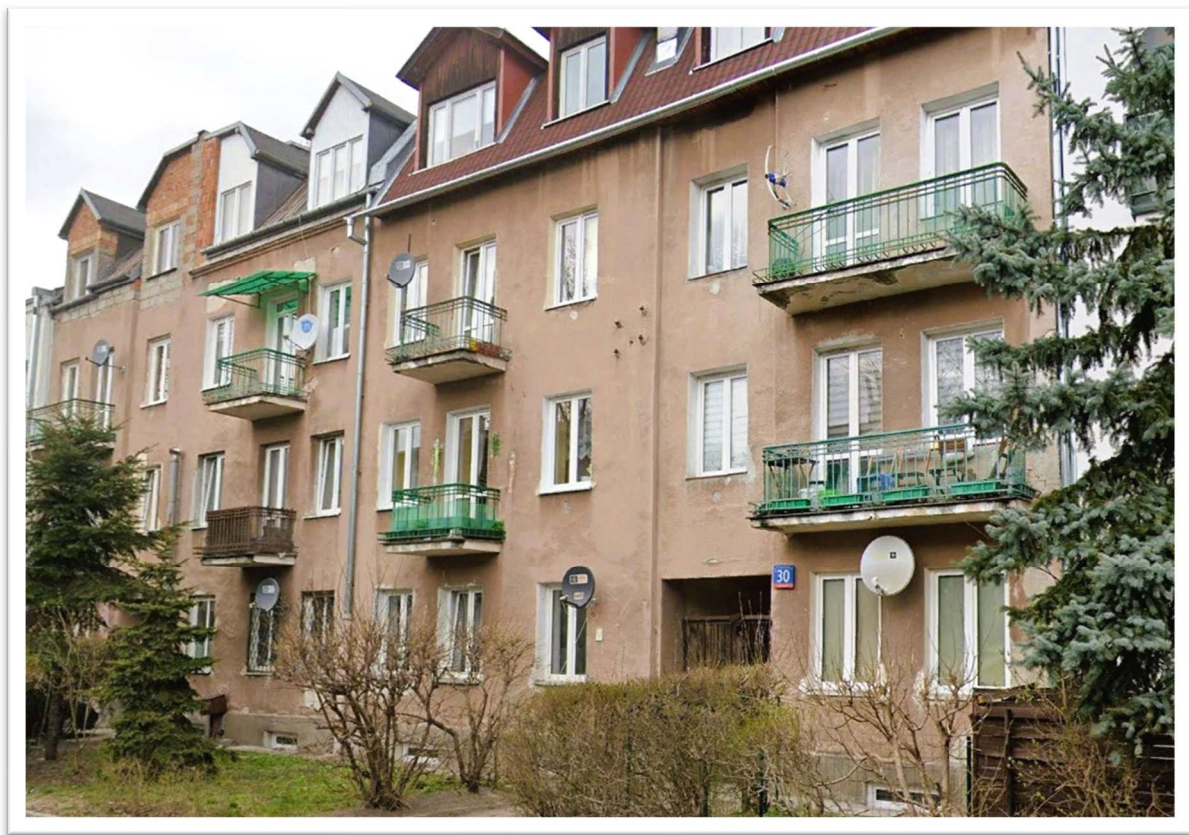
Ryc. 10. Współczesny wygląd kamienicy przy ul. Pustelnickiej 30 w Warszawie. Tutaj pod numerem 3 mieszkali Państwo Janina i Leon Lenkiewiczowie przed przyjazdem do Szczytna.
